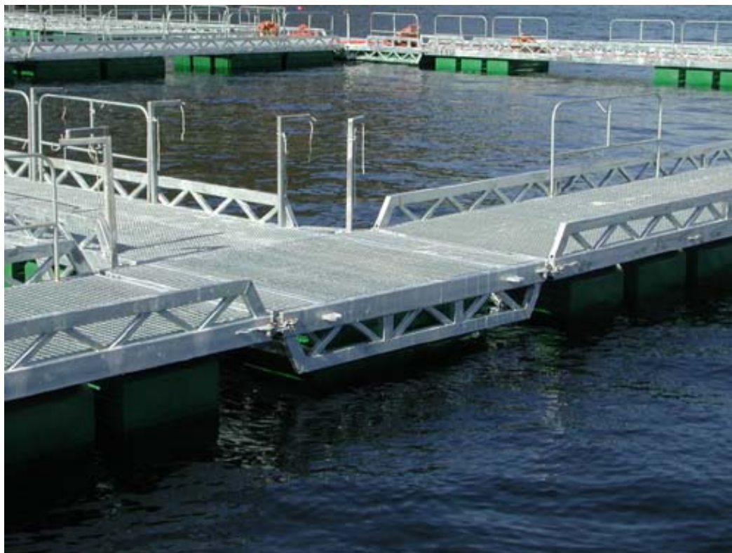
Figur B.1. NM 5000 anlegg med fagverkforsterkning.
