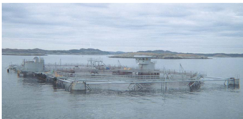
Figur 2.5. Fagverks stålanlegg, Storm.
